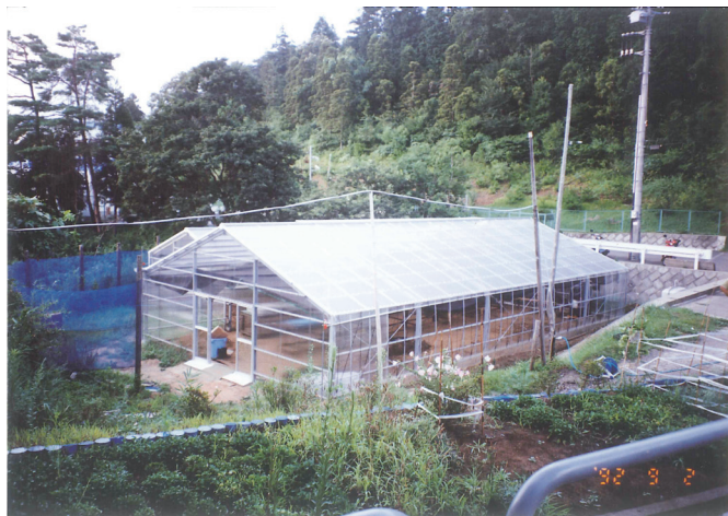
作業ハウス建設
