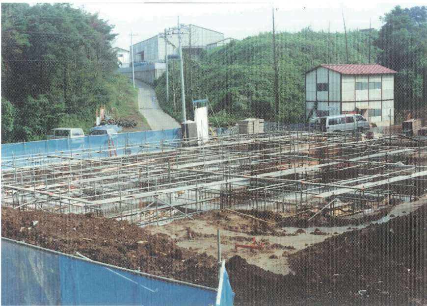
木の宮学園建設工事
