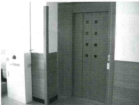
①・⑧エレベーター及び屋内消火栓の設置
