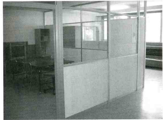
⑤多目的ホールの一部を屋内活動スペースに改修
