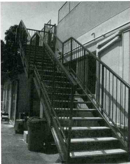
⑥屋外非常階段の改修
