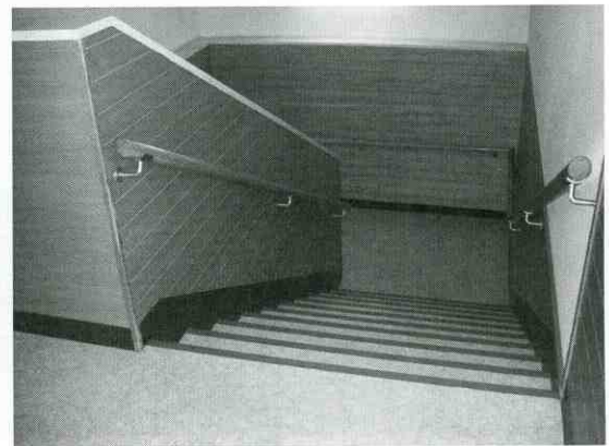
④階段・ホールを福祉用シートに張替
